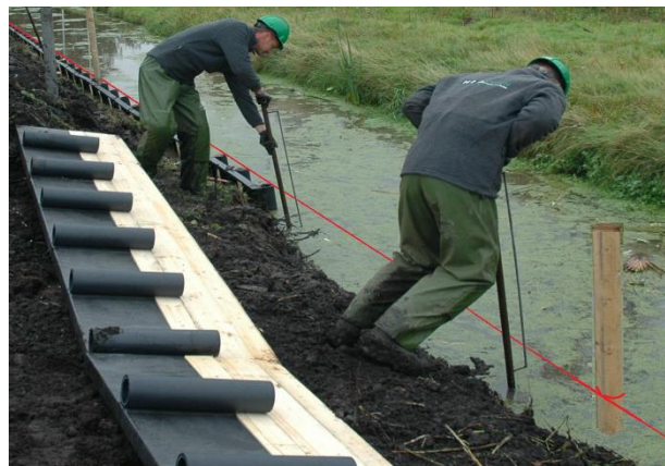
Afbeelding 3: Geleidestangen plaatsen en positie draadpaal
