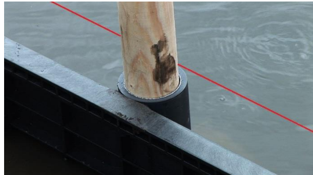
Afbeelding 2: Draad t.o.v. te plaatsen beschoeiing
