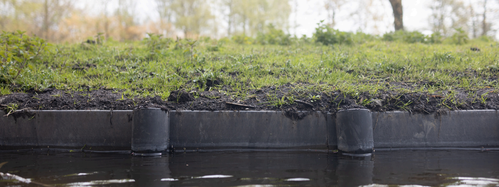
Afbeelding 1 - HDPE beschoeiing van HIP Groen in de buitenruimte
