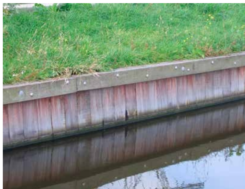
Damwand van tropisch hardhout
