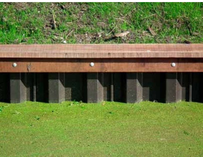
Kunststof damwand met afwerkrand van tropisch hardhout
