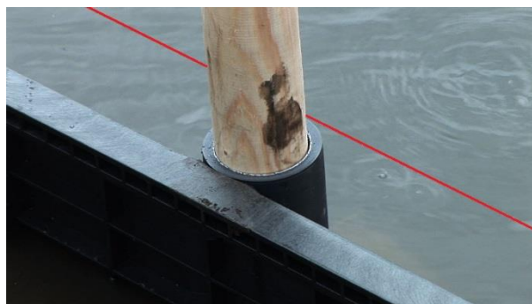
Afbeelding 2: Draad t.o.v. te plaatsen beschoeiing
