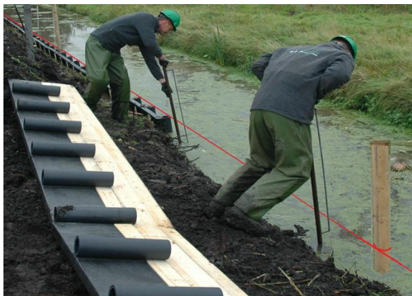
Afbeelding 3: Geleidestangen plaatsen en positie draadpaal
